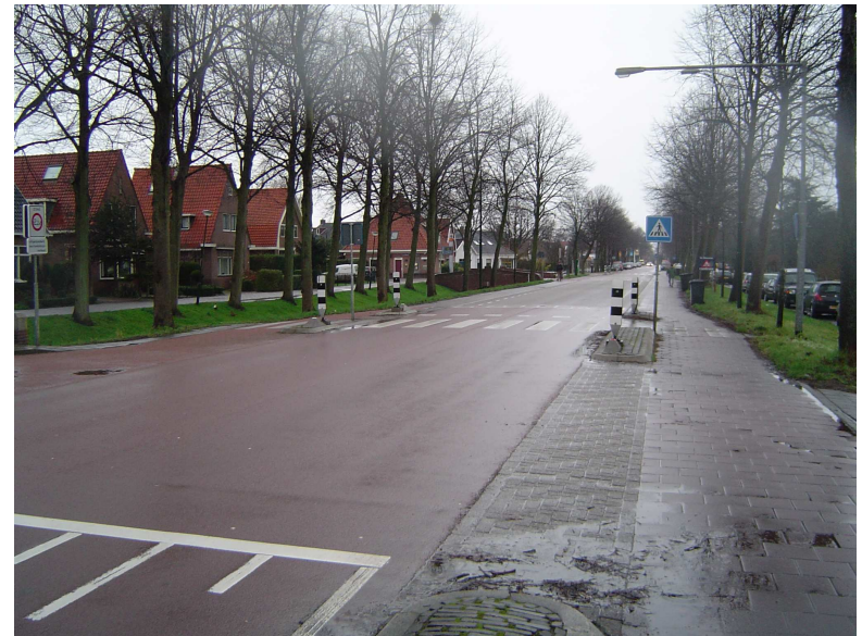
Figuur 1.1: Bestaande situatie op de Purmerenderweg
